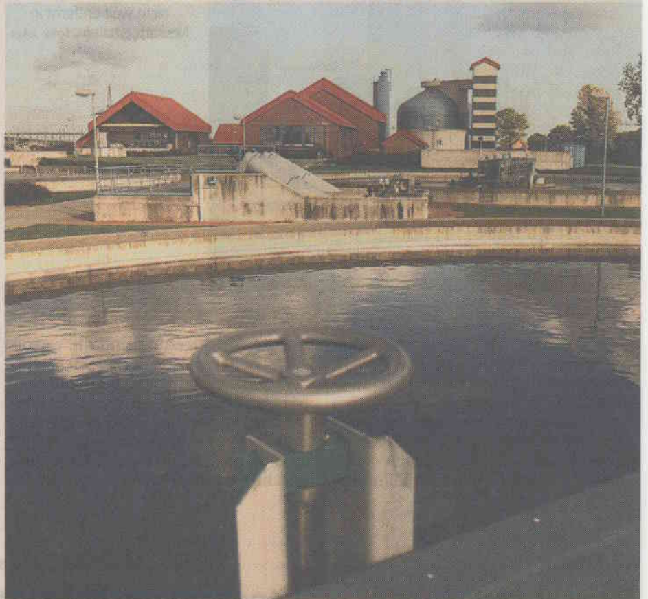
In der biologischen Reinigungsstufe fällt jede Menge Klärschlamm an. Ein neues Verfahren bereitet ihn jetzt für die Verwertung in Biogasanlagen auf. Foto: Envia
