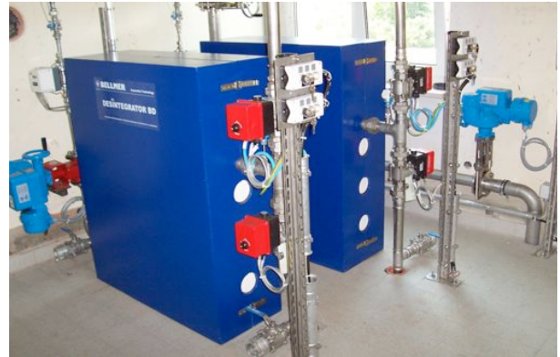
Abb. 1: Einbindung des Ultraschallreaktor in den Schlammbehandlungsprozess
