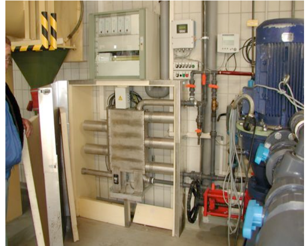
Abb. 1: Einbindung des Ultraschallreaktor in den Schlammbehandlungsprozess
